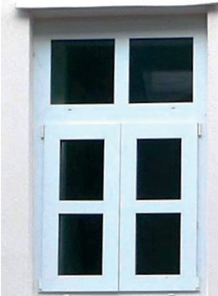
Dieser Fenstertyp war auch an Holstenstraße 37 zu sehen: Das klassizistisch-biedermeierliche Kreuzstockfenster aus dem frühen 19. Jahrhundert, original und in situ (hier ein Vergleichsbeispiel vom Haus An der Mauer 8).
