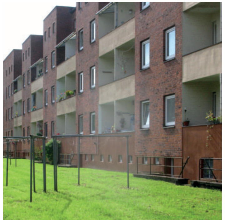
Rückwärtige Nordost-Fassade zur Wäschetrocknawiese; Fotografie: Verfasser, September 2019
