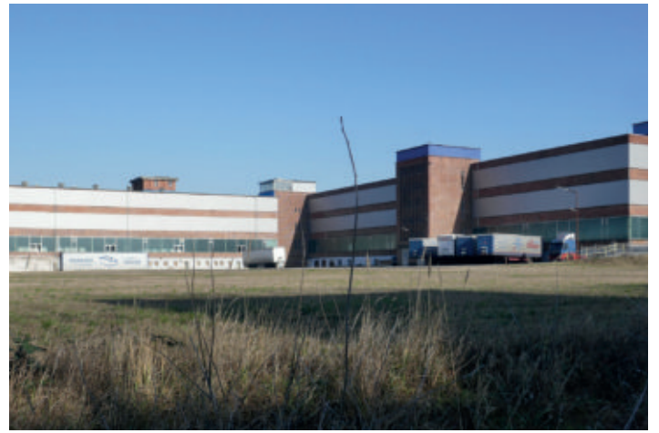
Die Flächen werden als LKW-Abstellflächen genutzt. Die Glasbänder sind zuhängend. Befürchtete man Verletzungen durch herunterfallende Glasscherben?
