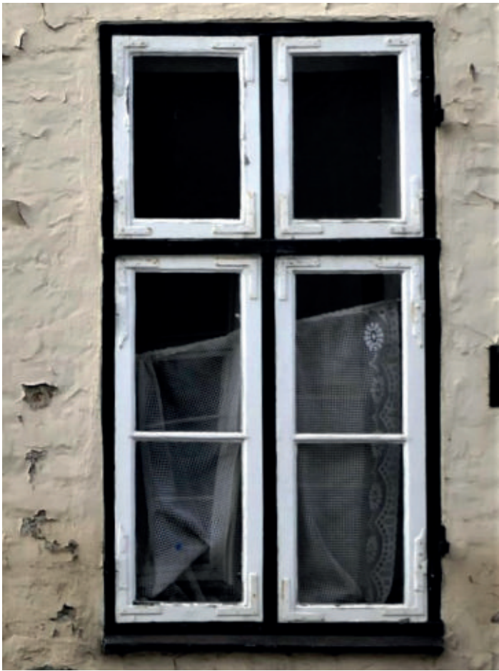
Dieser Fenstertyp war auch an Holstenstraße 37 zu sehen: Das klassizistisch-biedermeierliche Kreuzstockfenster aus dem frühen 19. Jahrhundert, original und in situ (hier ein Vergleichsbeispiel vom Haus An der Mauer 8).
