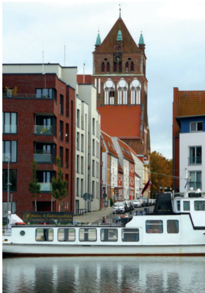
Greifswald, Blick über den Hafen die Brüggstraße hinauf zu St. Marien. In Bildmitte eine Hauszeile in „Greifswalder Platte“. Unten: Partien am „Oldtimerhafen“.
