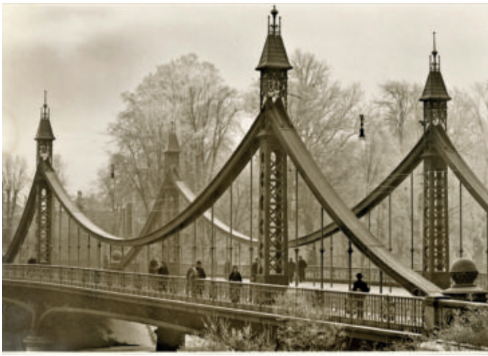
Mühlenbrücke in originaler Form (Foto Karl Braune 1936). Zum Stand der Sanierung: „Schlussendlich wurde eine erfolgreiche interdisziplinäre Zusammenarbeit ermöglicht“. S. 61.
