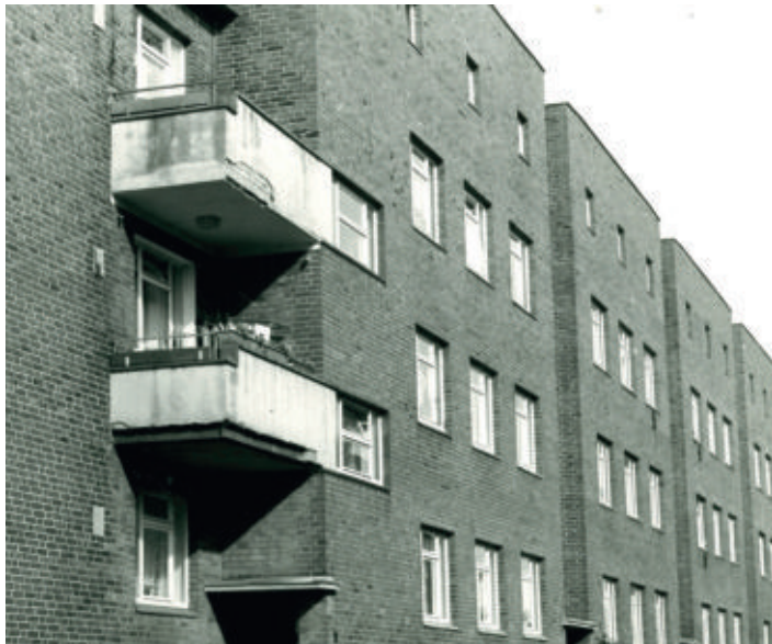
Südwest-Fassade an der Margarethenstraße, noch mit historischer Fenstergliederung; Fotografie: Alice Kranz-Pätow, Juni 1981
