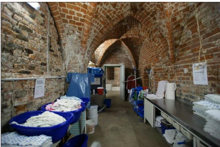
◀ Die Bilder unten zeigen den durch Fehlnutzung verursachten Steinzerfall der Gewölbekeller. Zentrale Heizungsanlage und Wäsche-Aufbereitung sind in mittelalterlichen Kellerräumen fehlplatziert. Klimatische Sanierung und Wiederherstellung dürften den Träger sehr teuer kommen.
