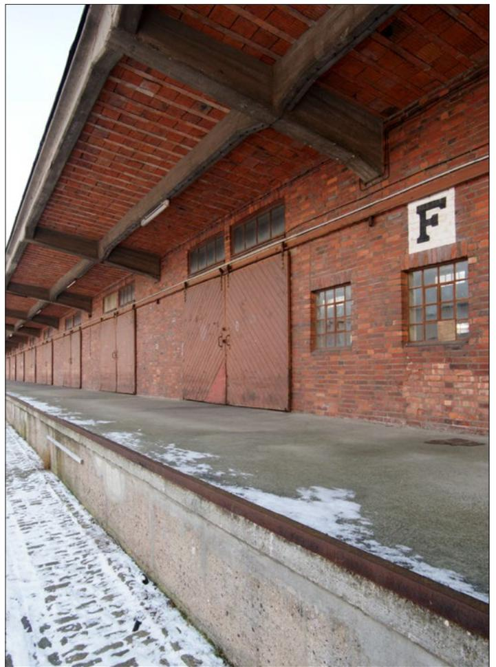
▲ Schuppen F, Nordwestseite mit durchlaufenden Rolltoren an hohem Anlieferungs-Perron unter vorspringendem Dach.
