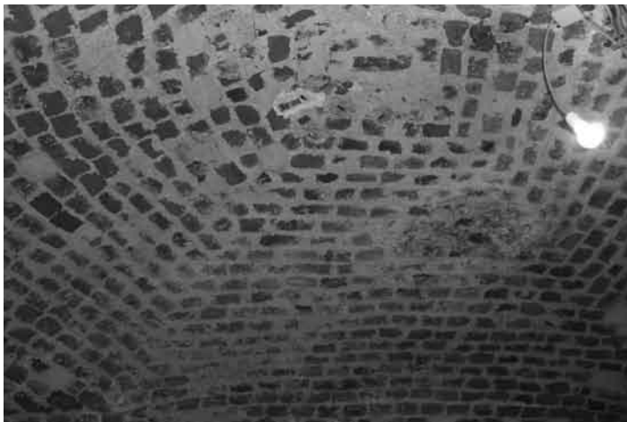
Blick in eine Kuppel. Fast alle Ziegel ohne Kalküberzug, fast alle sind in der Oberfläche geschädigt.
