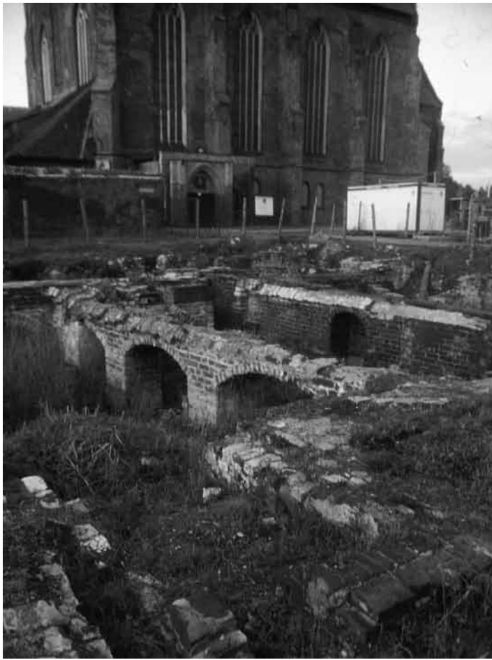
Die jüngsten Ausgrabungsflächen auf dem Gelände der einstigen Elbinger Altstadt. Gut erkennbar die gotischen Kellermauern. Im Hintergrund die Dominikanerkirche St. Marien. – In den ersten Jahren des Wiederaufbaus um 1990 setzte man die Mauern der neuen Häuser direkt auf die mittelalterlichen Mauerzüge.
