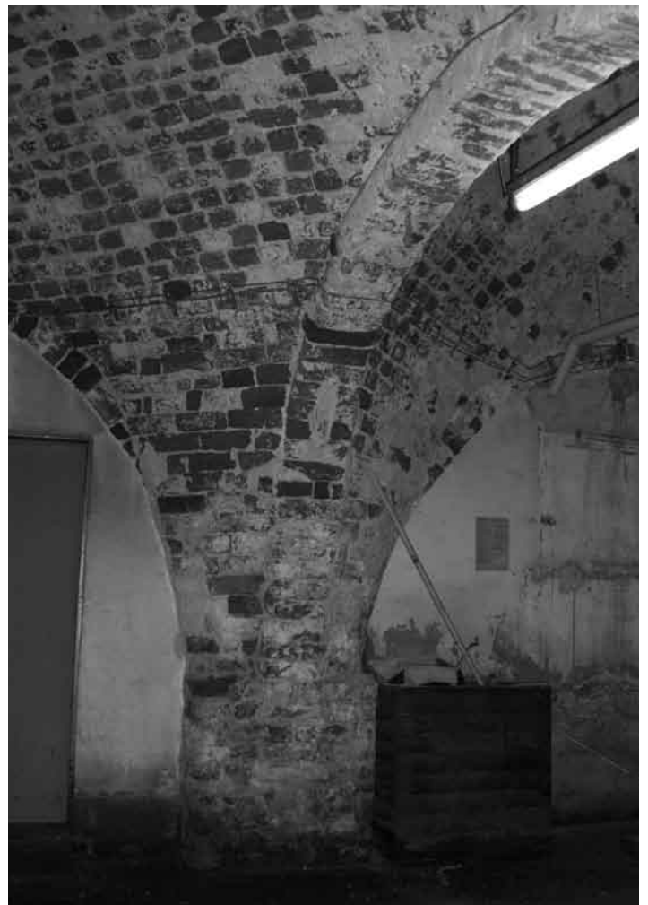
Einer der sechs Pfeiler. Überall starke Schäden. Die Abmauerungen (u. a. als Heizungsraum!) sind hier neu und sollten schnellstmöglich verschwinden.
