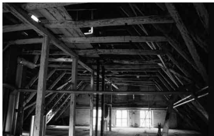
Der Crane-Konvent besitzt das (nach dem Rathaus) größte „profane“ Dach Lübecks – dendrochronologisch datiert auf 1283 (der Unterzug mit den Ständern ist neueren Datums).
