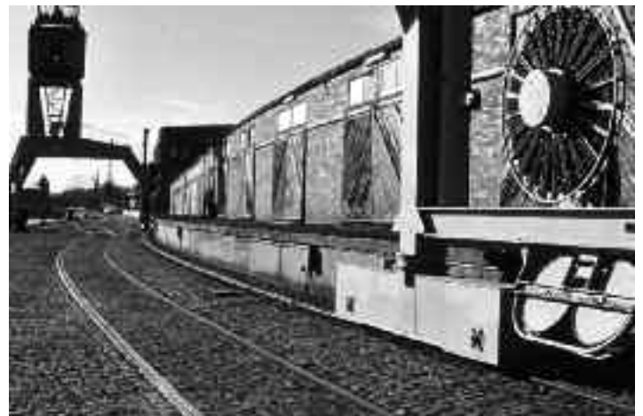
Alle Schiebetüren der Hafenhallen werden von eisernen Bändern gerahmt und diagonal versteift. Eine selbstverständliche Gestaltung, die bis heute „gut aussieht“. Oben: Langseite von Schuppen B, links eine Giebelfront, in der Mitte ein Rolltür-Detail, unten Schuppen F mit erhaltener Kranfahrt
