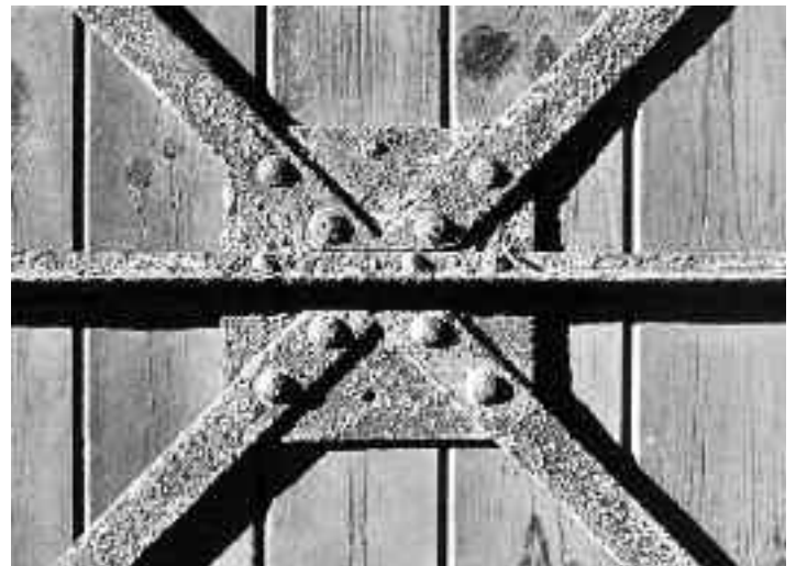
Alle Schiebetüren der Hafenhallen werden von eisernen Bändern gerahmt und diagonal versteift. Eine selbstverständliche Gestaltung, die bis heute „gut aussieht“. Oben: Langseite von Schuppen B, links eine Giebelfront, in der Mitte ein Rolltür-Detail, unten Schuppen F mit erhaltener Kranfahrt
