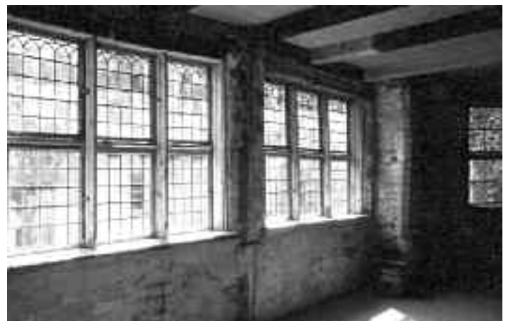
Die Bleifenster von innen. Von zwölf historischen Fensterflügeln besaßen noch sieben die ursprüngliche Verglasung. Vorsichtige Reparatur des Bleinetzes; die alten grünlich-violetten und schlierigen Gläser konnten gerettet werden (Ausführung: Glaser Gerhard Reincke aus Rukieten, südl. v. Schwaan). Ergänzung der fehlenden Flügel mit modernem Industrieglas, aber übernommener Bleizeichnung
