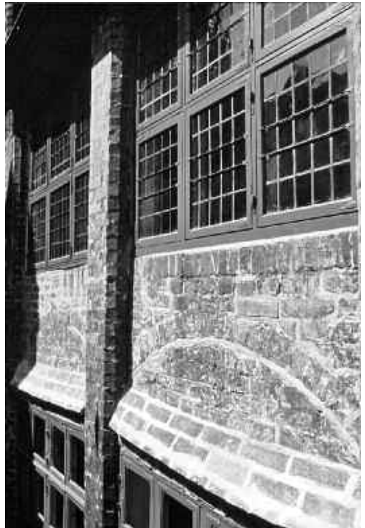
Im Obergeschoss des spätgotischen Flügels haben sich Lübecks älteste Fenster erhalten. Blick vom Fenster im 1. Querhaus auf die reparierte Blei-Verglasung
