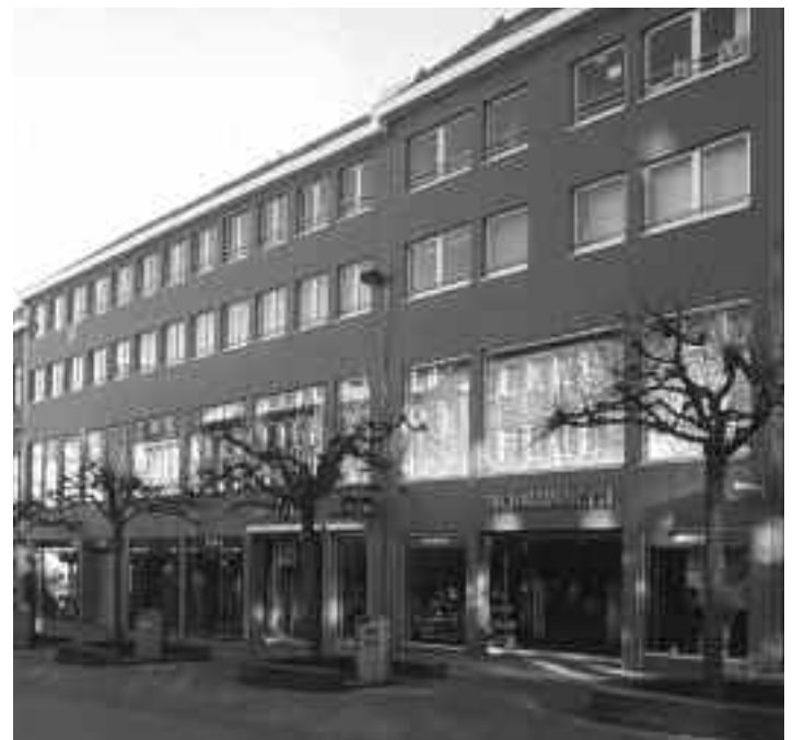
Breite Straße. Ostseite. Gegen mittelmäßige, oft schlechte Investoren-Architektur kann auch ein Gestaltungsbeirat wenig ausrichten
