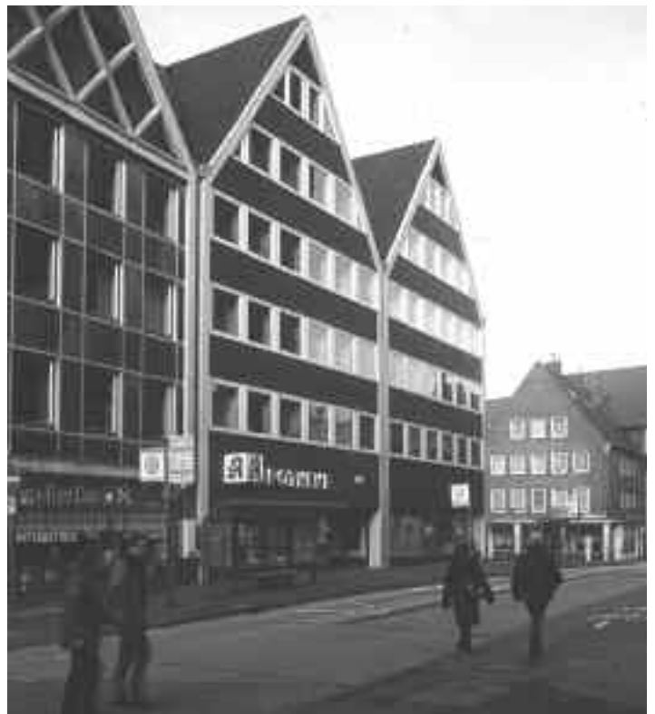
Schlüsselbuden 10-14: Wird solche Architektur einmal erhaltungswürdig sein?
