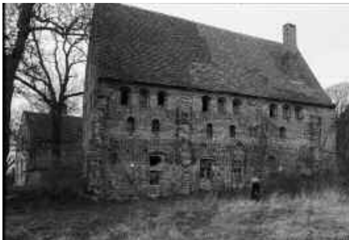
Das „Warmhaus“ der Antoniter-Niederlassung Tempzin. Von ähnlicher Kubatur wie die Lübecker Gertrudenherberge. Der denkmalbewusste Ausbau zu einem Pilgerzentrum läuft.
