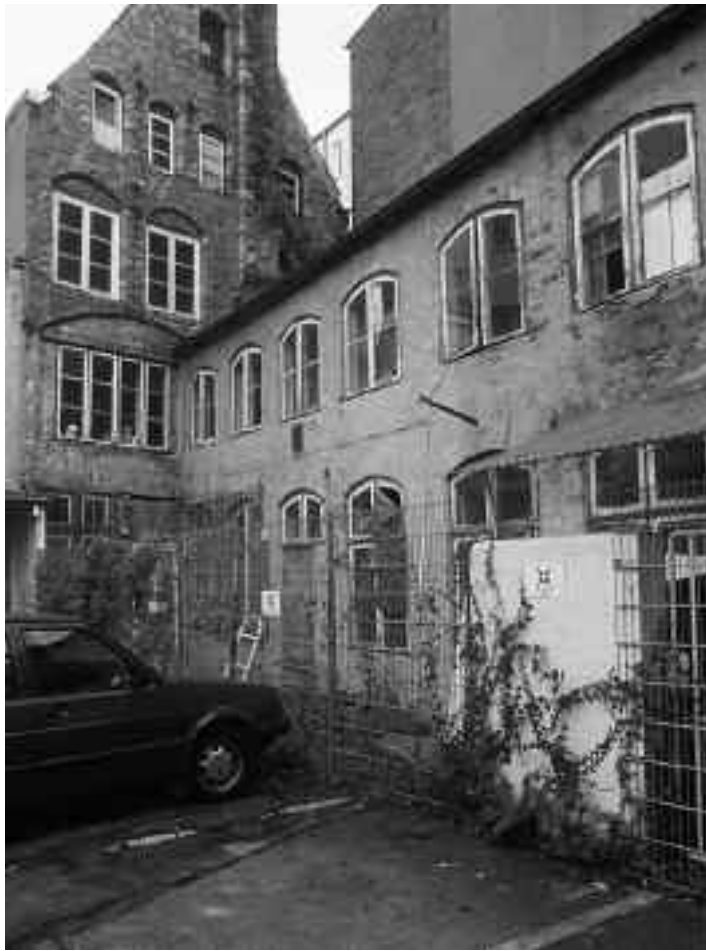
Königstraße 93, Hoffront. Typische Ausprägung der Jahre um 1600. Im Giebel stichbogig schließende Lüftungsluken. Bemerkenswert der alte Kamin im Verband mit der Giebelmauer: Er diente als Rauchabzug für die Kachelöfen, die sich vorn in den Flügelzimmern befanden. Rechts anschließend der Wohnflügel des 18. Jahrhunderts.
