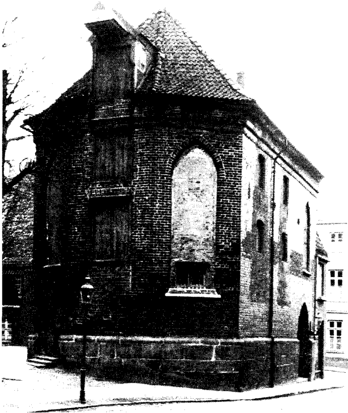
Maria-am-Stegel vor dem Umbau durch Wilhelm Schürer 1928. Gut erhalten die schwarzglasierte Ziegelhaut
