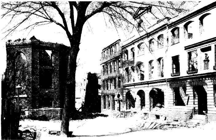
Maria-am-Stegel im März 1942: 1967 wurde das problemlos wiederherzustellende Gebäude abgebrochen, weil es zur Hälfte „auf der Mengstraße“ stand. Da sollten Autos fahren
