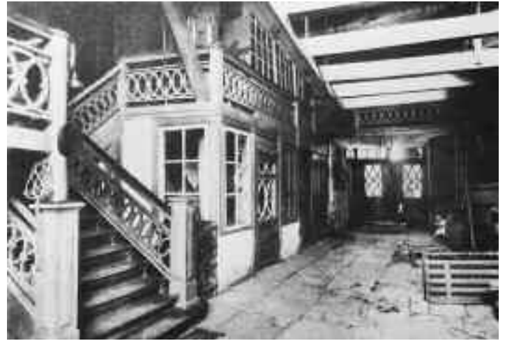
Wahmstraße 37, Braudiele um 1900. Kücheneinbau, Windfang und Kühlboden-Balkenlage sind verschwunden. Nostalgische Zusatz-Einbauten diskreditieren den bis heute erhaltenen Raum.
