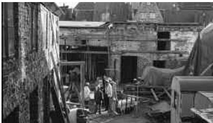
Untertrave 60. Begehung durch die BIRL im Oktober. Links der Flügel des 18. Jahrhunderts. Im Hintergrund wird das Querhaus neu entstehen - mit dem rekonstruierten „holländischen“ Kranenbalken-Giebel.
