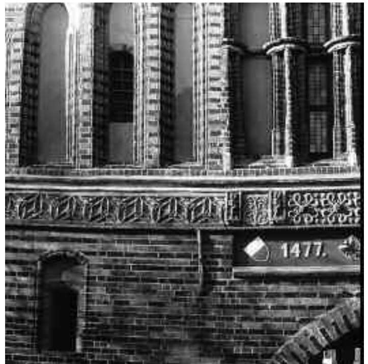
Holstentor, Stadtseite. Ausschnitt mit Terrakotten-Gesimsband. Die Friese sind (auf diesem Bild noch) von 1867
