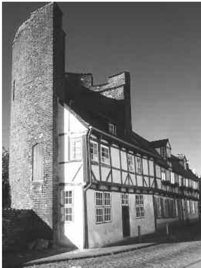
▼ Halbturm am Krähenteich – erhalten, weil sich an der Innenseite der Mauer im 17. Jahrhundert drei Häuser eingemistet hatten – „Eigentum verpflichtet“!
