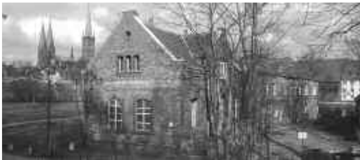
Wallstraße 25. Rechtsbruch in Form von Abbruch: Hier hat der Bauverein gegen verpflichtende Auflagen verstoßen
