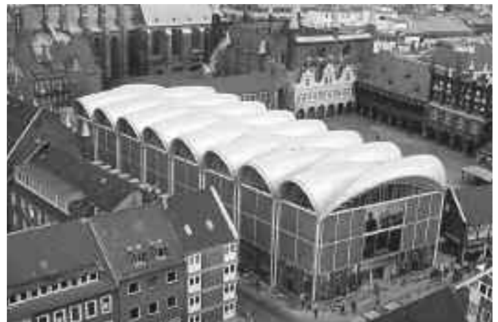
Petritrum-Blick 2005: Die seitlich weit und hoch hinausgeführten Schalen der neuen Kaufhaus-Dachlandschaft lassen von der Marktfläche kaum was übrig. – Ein totaler Fehlgriff auch das helle Dach: Es sagt überdeutlich, wer hier am Markt „Chef“ ist. Foto: U. Haarich
