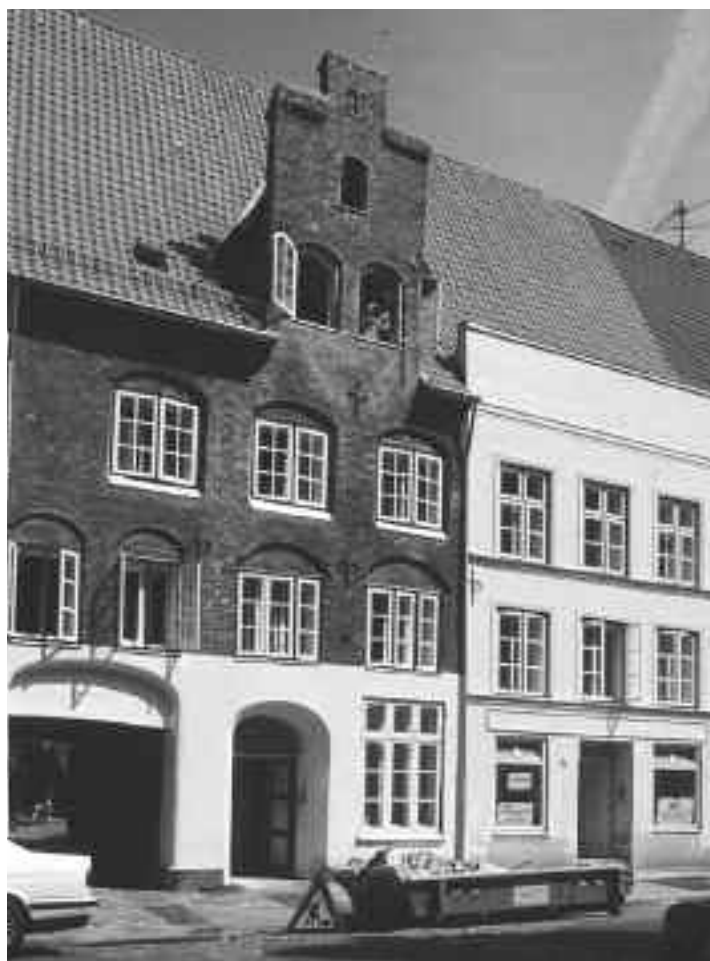
Dankwartsgrube 64-68. Reihnhaus aus drei Einheiten von 1572. Bauherr war der Immobilien-Unternehmer Gert Ruyter. Die hier realisierte Dreigeschossigkeit ist eher selten. Das zweite OG und das hohe Dach dürften wegen der Nähe zum Binnenhafen Obertrave gewerblich genutzt worden sein (Salz- und Getreidespeicher). – Typisch die kargen Formen der „Lübecker Renaissance“: Fensteröffnungen in Stichbogenblenden, Profile aus Fasensteinen, Zwerchhaus mit kleinem Treppengiebel, Maueranker in Lilienform. Die einstige Rotfassung des Mauerwerks bei Nr. 68 (links) wurde anlässlich der Sanierung zaghaft wieder angedeutet
