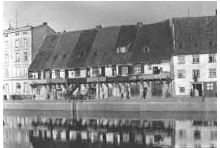
Ein Reihenhaus? Eher ein „Sahlhaus“: Der mächtige Baukörper An der Obertrave 20/21 mag als Ganzes ein Rest des Wirtschaftshofs des Zisterzienser-Klosters Reinfeld gewesen sein (die Formen der Öffnungen in beiden Geschossen sprechen dafür, ebenso der im Erdgeschoss links erkennbare gotische Mauererbau). Der Durchbau des Speicher-Unterbodens zu Wohneinheiten durch einen „Unternehmer“ dürfte noch im 16. Jahrhundert erfolgt sein. - Diese bemerkenswerte „Umnutzungs-Architektur“ wurde 1940/41 durch einen Luftschutzbunker „ersetzt“. Die Niederlegung der „ungesunden Wohngelasse“ war aber auch Teil der NS-„Sanierungs“-Politik
