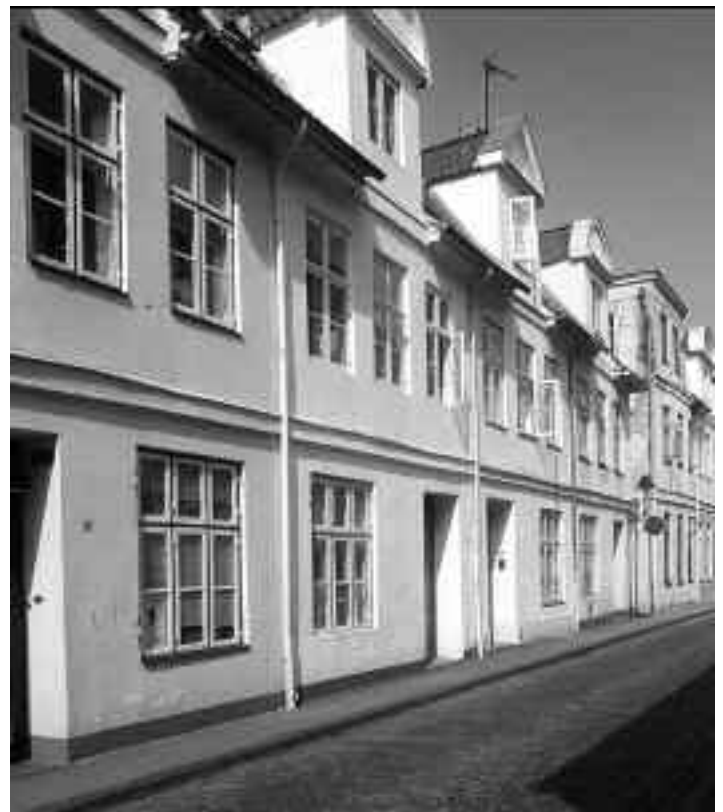
Fegefeuer 23-29. Eine erst 1804 errichtete Reihe (auf dem freigeräumten Großgrundstück einer Domkürrie). Die klassizistische Außen-Erscheinung daher fast unverändert erhalten: Zwerchhäuser mit alternierenden Dreiecks- oder Segmentbogengiebeln, Traufbrett mit „antikem“ Fries, Blockzargenfenster, hell gestrichener glatter Putz, Haustüren. Eine schöne Einheit!
