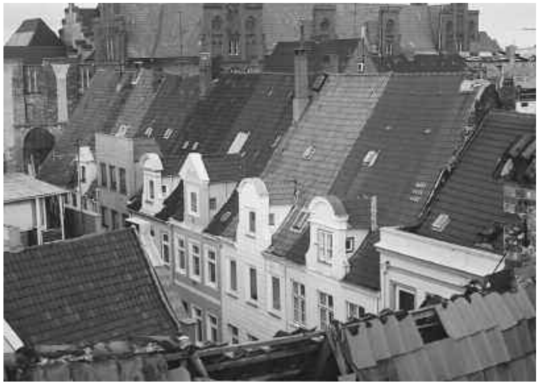
Kleine Burgstraße / Ecke Hinter der Burg. Sieben unterschiedlich gedeckte Dächer bei durchlaufendem First und durchlaufender Trauflinie – Lübecks ältestes Reihenhäuser. Die auf 1291 (d = dendrochronologisch) datierten und weitgehend erhaltenen
