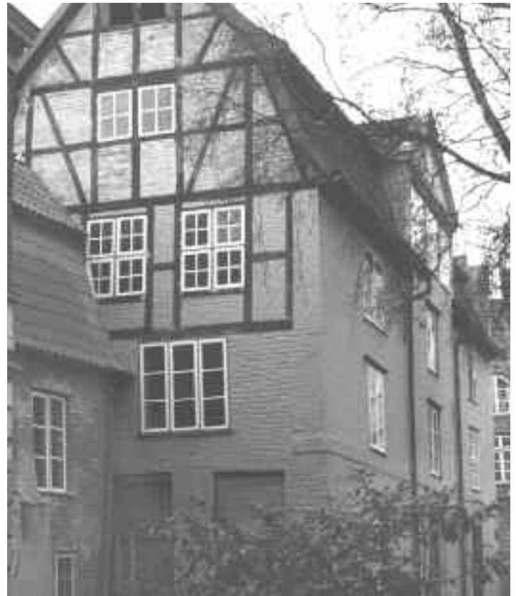
Weiter Lohberg 2, Eckhaus zum Langer Lohberg. Ein Gewerbebau des 18. Jahrhunderts – zuletzt wurde – im 19. Jahrhundert – hier Seite gemacht. Nach langer Vernachlässigung jetzt im äußeren Bild wiederhergestellt. Alte Fenster sind nur an der Traufseite erhalten, die Giebelfront zum Langer Lohberg wurde „biedermeierlich“ neu befenstert. – Kleines Bild links: Weiter Lohberg 13/15. Das Rokoko-Doppelhaus mit den z.T. noch originalen Biedermeier-Fenstern wurde hellgelb gestrichen.
