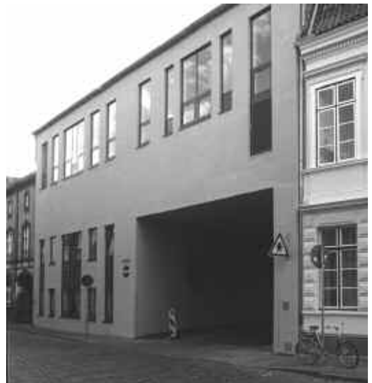
Francke-Schule. Umbau des Turnhallenblocks 2003
