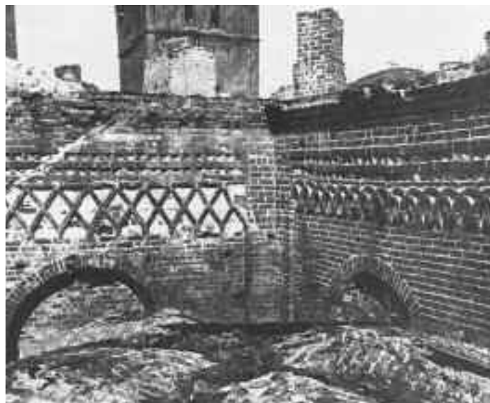
Lombardische Ziegel-Friese als Abschluss der Hochschiff-Wände
