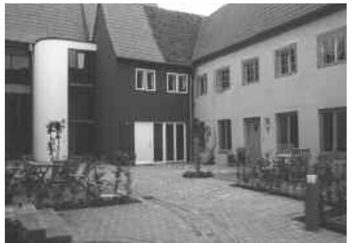
Fischergrube 84. Der rückwärtige Hof. Das Flügelhaus rechts einst zur Fischergrube 72 gehörig, links anschließend das erneuerte Querhaus mit Treppenturm, dahinter die Glasfront des Speicherhauses
