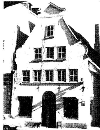
▲ Beckergrube 76. Backhaus-Grundstück seit dem Mittelalter. Eine noch zu „entdeckende“ Fassade. Die Maueranker weisen auf den gotischen Kern (Dachstuhl!) und die Veränderungen des 16. Jahrhunderts hin. Die große Voluten-Kontur und der winklige obere Abschluss wären um 1730/40 denkbar; die gerade verlaufenden Schweifen wohl eher als jüngere „Korrektur“. Hier wird man wohl forschen dürfen - das Haus steht seit langem zum Verkauf - und zur dringend notwendigen Sanierung an! Foto um 1980
