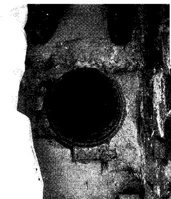
Blick in die Tiefe: Auf Höhe der einstigen Nonnen-Empore sind die Schiffs-Pfeiler brückenartig verbunden; der achteckige Pfeiler-Querschnitt ist hier also nicht sichtbar. Das 40-cm-Bohrloch verläuft genau in Pfeilermitte. Technisch durchaus eindrucksvoll - mit den Bohr- und Traversen-Löchern ist aber ein gravierender „Abgang“ an historischem Material verbunden (die Füße gehören dem Fotografen)
