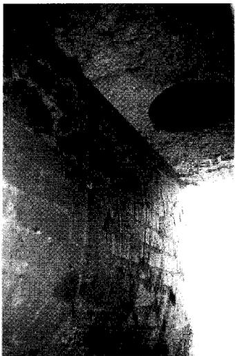
Blick in den Sägeschnitt der Traversen-Öffnung. Ein sehr interessanter Befund: Im weitgehend durchgebundenen Ziegel-Mauerwerk sind auch Findlinge erkennbar - sauber durchtrennt. Oben das 40-cm-Bohrloch für den Last-aufnehmenden Pfeiler
