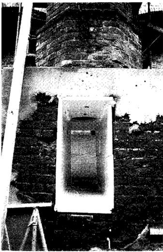
Durchtrennung eines Pfeilerfundaments. In diese rechteckige Öffnung wird eine armierte Beton-Traverse eingesetzt. Die Last des über der gotischen Ruine entstehenden Neubaus wird über eine Rundstütze durch den ausgebohrten Pfeiler geleitet (s. runde Öffnung oben) und von der Traverse aufgenommen; diese Traverse setzt die Last auf neue, seitlich angefügte Fundamente ab. Das alte Mauerwerk und der neue Betonguss sollen keinen Kontakt haben, heißt es
