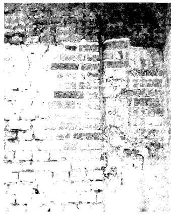
So wird angehübscht: Damit die schäbige Oberfläche der Fenstervermauerung den Kunstgenuss nicht stört, muss ein „Fugenkünstler“ die ruppige Wand glätten. Weder eine denkmalpflegerische noch ein funktionale Logik
