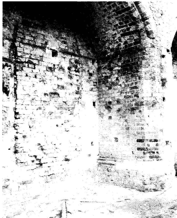
Erste Einsatzkapelle (von Westen): Zu sehen ist die rechte Hälfte eines der seit 1875 vermauerten fünf Zwillingfenster. Die Fenster werden nicht geöffnet. Das ruppige Füll-Mauerwerk bleibt. - Der eingezogene Strebepfeiler rechts zeigt in seinem Sockelbereich Reste der einst qualitativollen Detail-Architektur: Sandstein-Profile und Glasursteine
