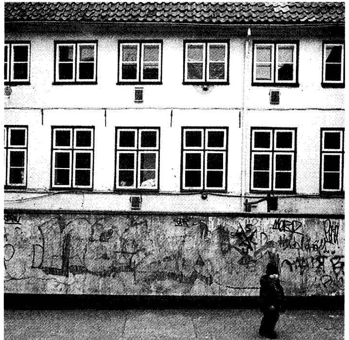
Glockengießerstraße 44. Flügel am Tünkenhagen. Der prägende biedermeierliche Zustand wird wiederhergestellt, die Renaissance zugedeckt (Bild vor Beginn der Sanierungsarbeiten)
