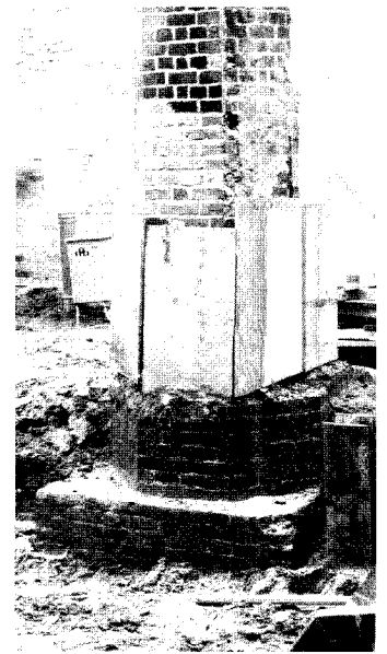
Pfeiler „S 2“, der zweite der Südseite. Ein schöner Befund, den man selten zu sehen bekommt (September '01). Der obere Teil des sorgfältig gemauerten Fundaments liegt frei. Der ehemalige Kirchenfußboden muss wenig darüber gelegen haben. Der Museumskeller, der hier ausgehoben wird (Toiletten etc), stellt eine durchlaufende Betonwand davor.
