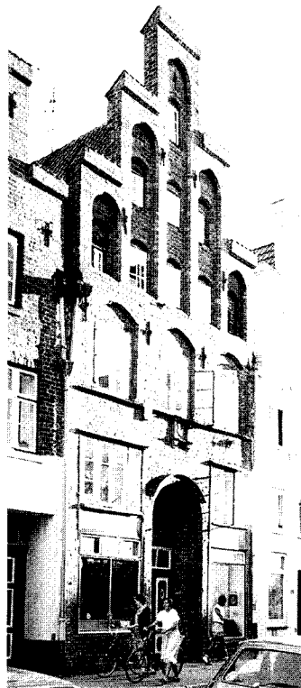
Glockengießerstraße 26. Fast unverändert erhalten. Die klassische Fassade der „Nachgotik“, 1572 als Front eines Brauhauses erbaut. Unterboden scheinbar als Wohn-Etage ausgebildet. Profile nur mit einfacher Fase. Alle Fenster jünger (Foto 1988)
