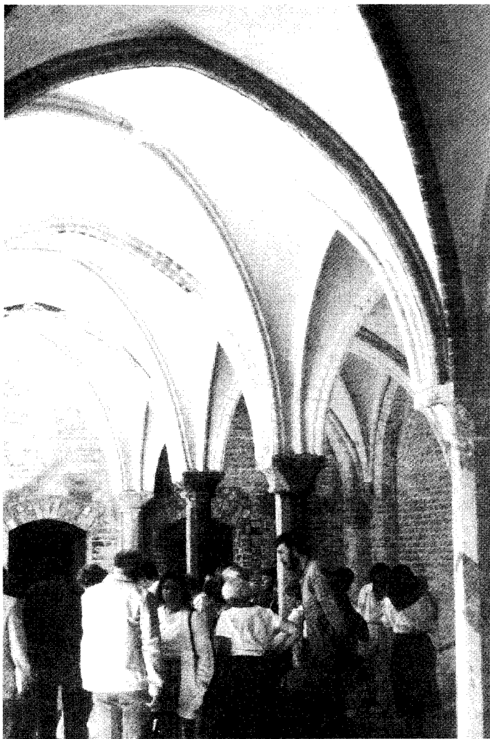
"Die BIRI" 1985 im Erdgeschoßsaa. des "Hospitals". Die Um- und Einbauten der Gerichtszeit sind entfernt, die Gewölbe bereits repariert und wieder gekalkt. Die ehemalige Funktion des Hospitals ist nicht eindeutig; die noch gut erhaltenen Reste einer Steinofenheizung ("Hypokausten") könnten wie auch die Wandnischen zwischen den Fenstern an der Ostseite auf Bettenstellen verweisen. Doch der repräsentative Schmuckfußboden bleibt dazu ein Rätsel. - Die beiden Obergeschosse zwecks Wohnung-Durchbau zur Gerichtszeit völlig entkernt.
