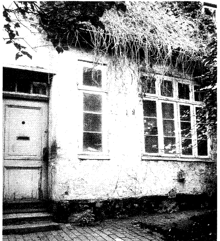
Pelzergang, Huxstraße 70. Hier steht noch eines der letzten von Sanierung und Anhebung „unberührten“ Ganghäuser: neben der biedermeyerlichen Tür ein schmales, 1-flügeliges Fenster, das die „Diele“ erhellt (hier ein schmaler Flur), rechts das breite Fenster der „Dornse“, die „gute Stube“. Insgesamt die verkleinerte Disposition eines „normalen“ Lübecker Hauses.
