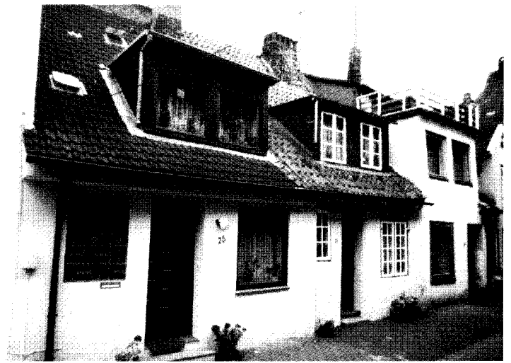
Blohms Gang, An der Obertrave 50. Die Gänge am Binnenhafen-Quartier Obertrave zeigen heute durchweg ein uneinheitliches Bild: Umbauten, Aufstockungen, Total-Neubauten nach Abbruch sorgen heute, wenn man es positiv formulieren möchte, für eine „malerische“ Wirkung. Für Denkmalschutz besteht hier kein Anlaß mehr - vielleicht aber mal für behutsame stadtbildpflegerische Reparaturen (das Foto ist historisch - der Zustand nicht). - Vermutlich wurden die einzelnen Ganghäuser hier recht früh privatisiert. Man kann aber auch deutlich erkennen, daß die „Obertravianer“ immer zu ihren Häusern gestanden haben und der Altstadt treu geblieben sind - und das ist hier die Hauptsache.
