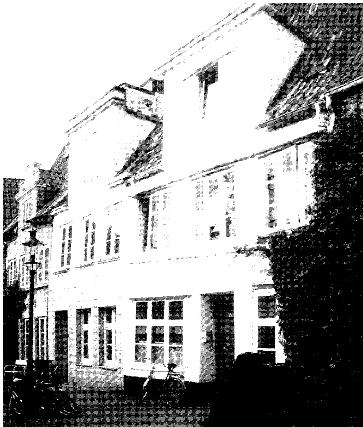
Torweg Engelswisch 33 Nordseite. 1531 erbaut. Diese ausgesprochen stattlichen Häuser haben die Struktur des 16. Jahrhunderts bewahrt: Dielen mit Dornsen, ausgebauter Ober- (=Schlafgeschoss) sind erhalten bzw. sind nachweisbar. Auch Reste von Wandmalereien sind aufgetaucht. Denkmalschutz besteht noch nicht.
