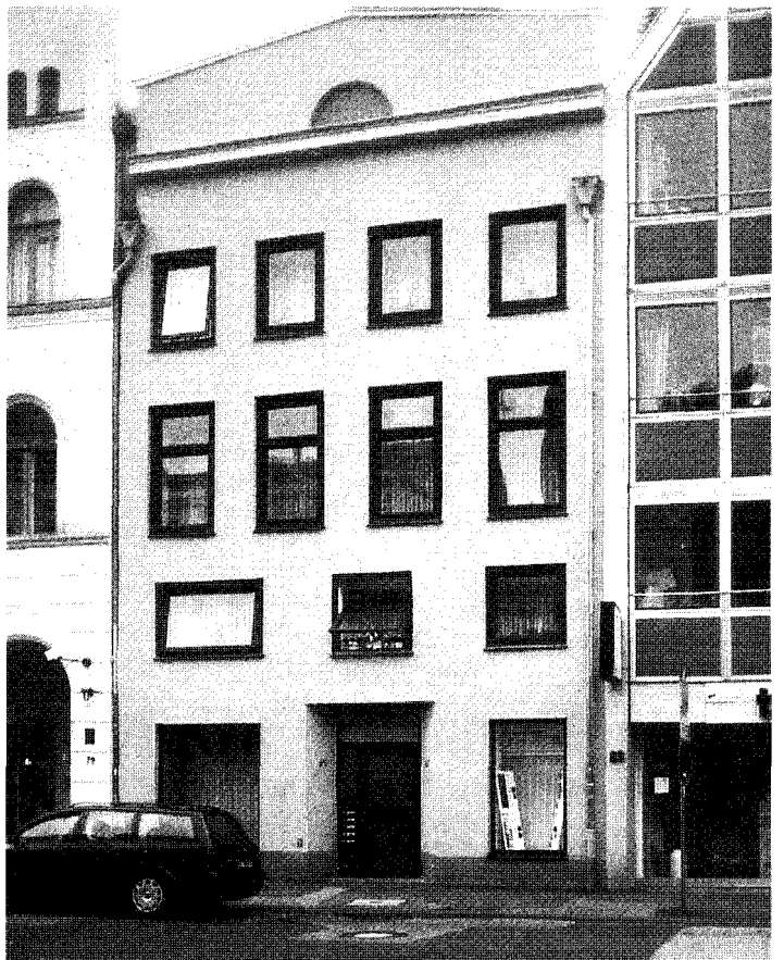
Wahnstraße 81. Klassizismus vor Renaissance. In den 60ern (oder noch später?) versimpelt. Die Hoffassade zeigt, wie schön alles mal war. Auch hier: Reparatur ist angesagt.
