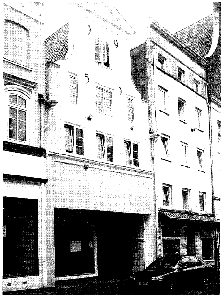
Wahnstraße 65. Die Fassade ist nicht von 1951, wie der Zahlenanker vermuten läßt. Eher dürfte 1591 zutreffen: Renaissance, um 1800 und noch einmal vor 30 oder 40 Jahren verändert. Die zurückgesetzte Laden-Höhle ist weder angenehm noch verkaufsfördernd: hier tut Haus-Reparatur dringend not.
