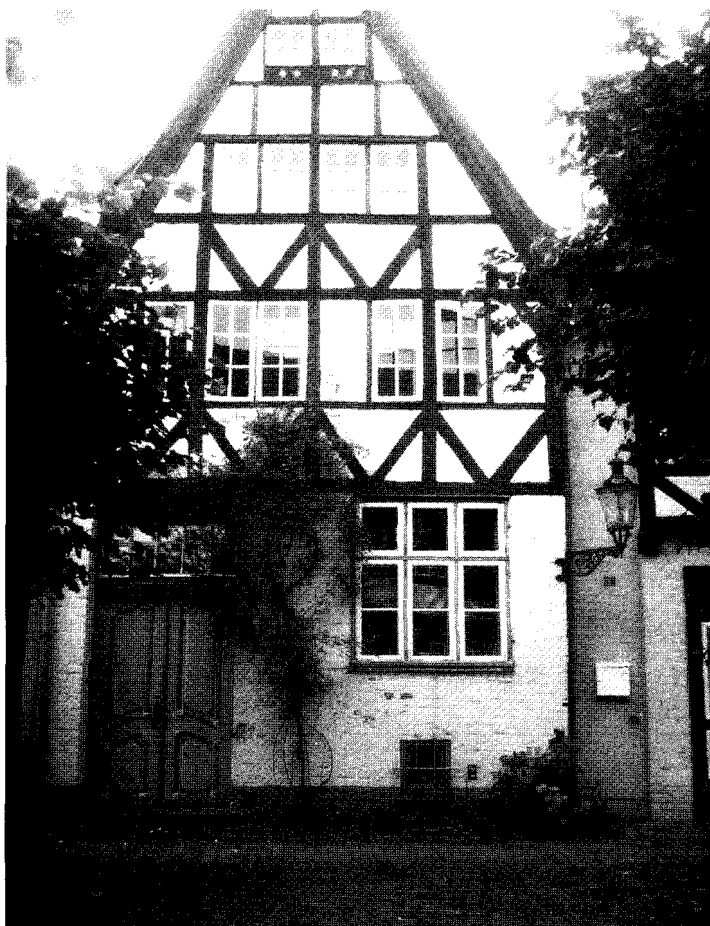
Durchgang Wahnstraße, Haus 23. Der seltene (einmalige?) Fall von giebelständigen Buden in einem Gang. Fachwerkbauten von etwa 1600, vermutlich seit Mitte des 18. Jahrhunderts unter Putz. Giebelständige Buden gab es eigentlich nur auf dem Markt und in Nähe des Marktes. Wegen des Total-Verlusts der gesamten Markt-Topografie hätten die beiden Giebelhäuser im Durchgang unbedingt erhalten werden müssen. Doch nur Nr. 23 hat die „Menschen-Unwürdigkeits“-Phase überlebt und ist in den 80er Jahren vorbildlich saniert worden. Nr. 22 ist ein schauerlicher Nostalgie-Neubau von 1975.
