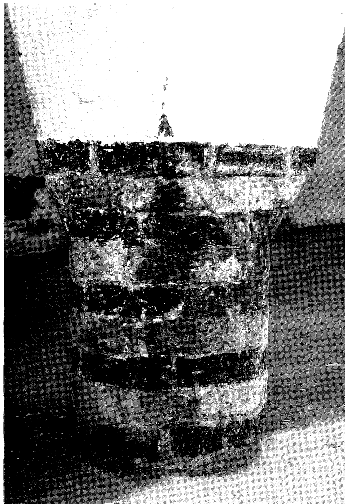
Königstraße 51. „Säule“ des Kaufkellers. Die gerundeten Formsteine, die Glasuren sowie das ebenfalls aus Formsteinen zusammengesetzte Trapezkapitell machen eine frühe Entstehung sicher - um 1260. Das eher dem spätromanisch-staufischen Schmuckstil zuzuordnende Detail (vergl. Domvorhalle Ratzeburg) ist einzigartig und auch nicht typisch für die eigentlich eher schmucklos gehaltenen „offenen“ Keller.
