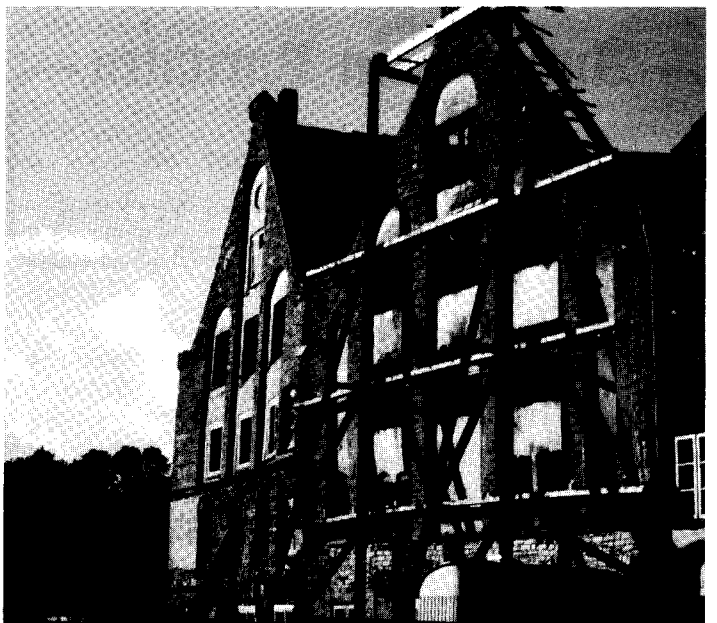
Stahl-Stützgerüst vor ausgebrannten Speichern Dankwartsgrube 72/74 (1984).
