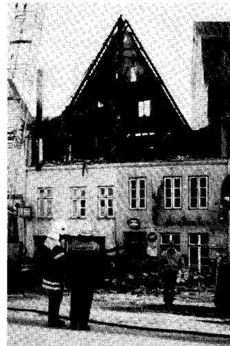
Die Vorderfassade ist abgetragen. Schwarz verräuchert zeichnet sich der hofseitige Rückgiebel vor dem Himmel ab. Die Abbruchfirma Rieckermann kann ihre reichen Erfahrungen einbringen.
