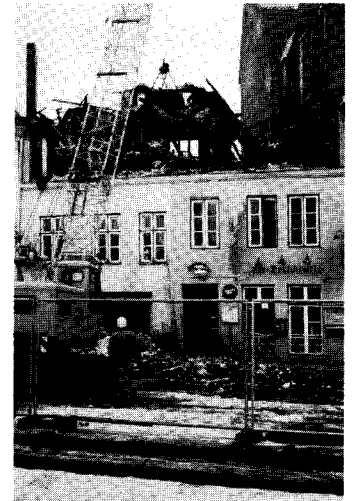
Die Rückfassade fällt. Nach Abfuhr der letzten Container mit verkohlten Balken, Brandschutt und Trümmern kann die Untertrave wieder für den Verkehr freigegeben werden.
