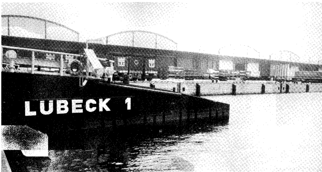
An beiden Längsseiten des Hallenblocks – oben die Land-, unten die Traveseite – ragt die Bogenkonstruktion, ein „Zitat“ der ehemaligen Krages-Hallen, übers aufgehängte Vordach hinaus.
