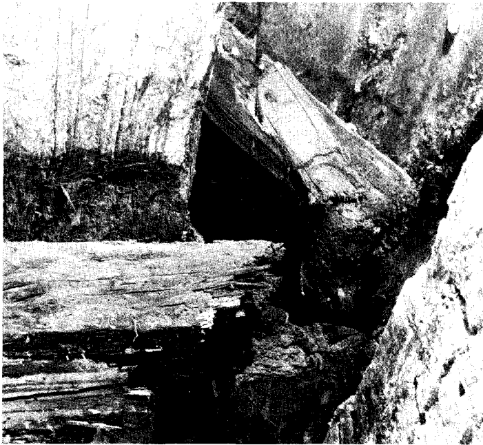
2 Sanierung praktisch: abgefaltete Dachbalken und Sparren und 3 Anlaschen als unkomplizierte Rettungsmaßnahme.
