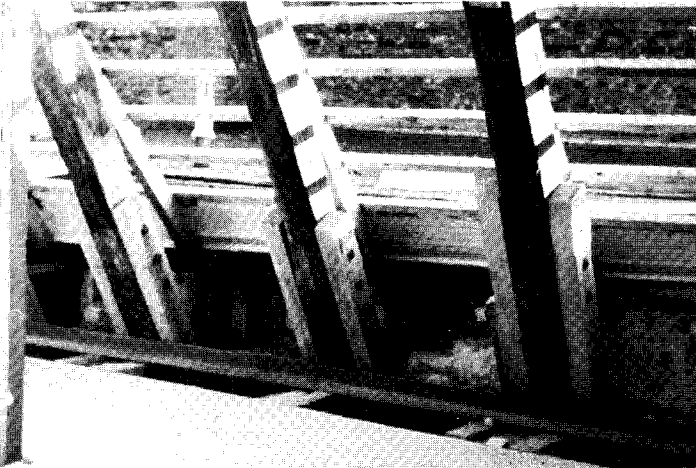
2 Sanierung praktisch: abgefaltete Dachbalken und Sparren und 3 Anlaschen als unkomplizierte Rettungsmaßnahme.
