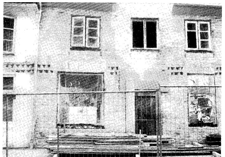
Anschauliche Denkmalpflege: Der „Sägefries“ und die mit Fasensteinen gemauerten Obergeschoßöffnungen, die den Steinverband sichtbar belassende dünne Kalkschlemme verdeutlichen die bis ins Mittelalter zurückreichende Baugeschichte (Hundestraße 56).
