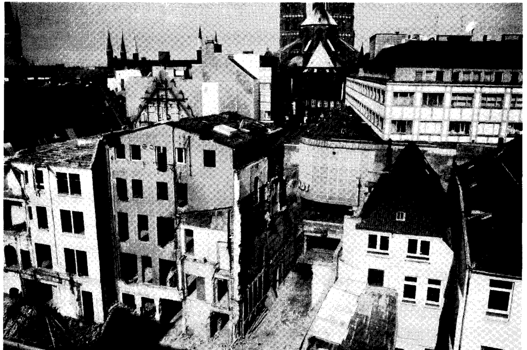
Palmarum '92: Der Überblick über die Königstraßenfront (Zustand: Mitte Mai) zeigt die prominente Lage der ehemaligen, inzwischen z. T. verschwundenen Kaufmannshäuser Nr. 49–57 am östlichen Rand des ehemaligen Marktbereichs. In Bildmitte über 2 Geschosse eine gotische Brandwand.
