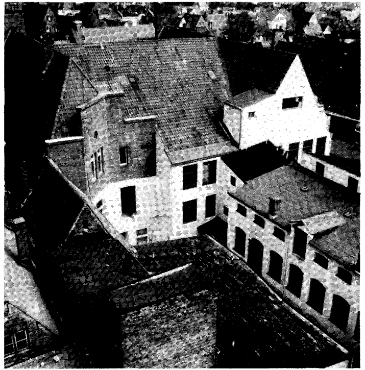
Palmarum '92. „Martens Backbedarf“ (Dr.-Julius-Leber-Straße) vor dem Verschwinden. Stadtplanerisch und volkswirtschaftlich widersinniger Totalabbruch einer durchweg intakten und nutzbaren, im Vorderhaus sehr repräsentativen Bausubstanz, der mit moderaten Teil-Entkernungen und Modernisierung der Haustechnik zu helfen gewesen wäre. Geopfert auch eine gotische Brandwand mit Malerei-Befunden.
