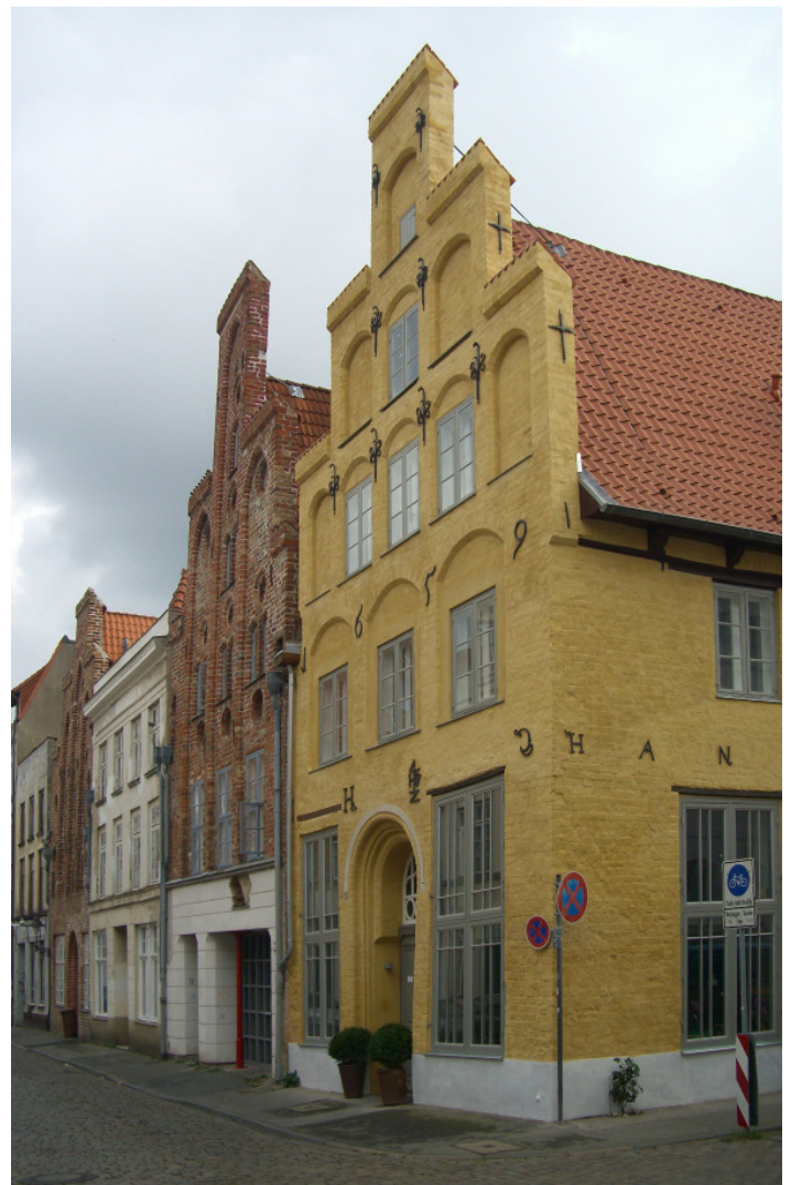
Beispiel aktueller Sanierungspraxis: Hundestraße 62 und weitere Objekte sowie Detailaufnahmen von Befunden dienen der Illustration im neuen Leitfaden des Denkmalamts.
