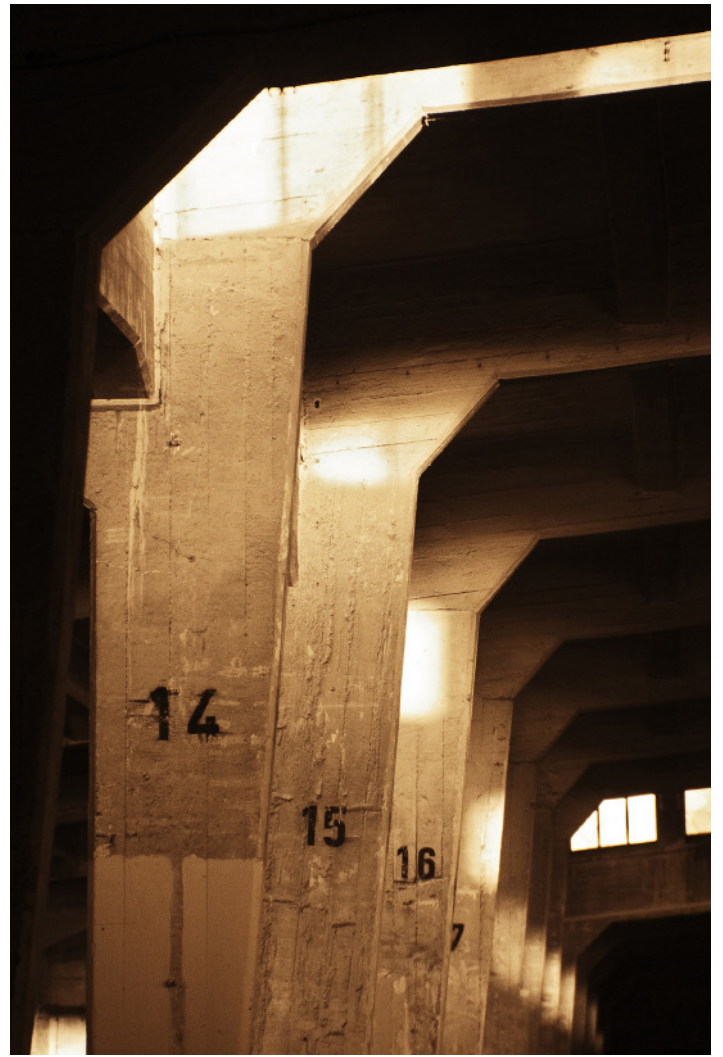
Die Reihung der nordwestlichen südlichen Mittelrahmenstützen im Schuppeninneren mit einem Abstand von 9,5 m je Joch. Rund 3.000 m 2 Fläche werden so weitgehend barrierefrei mit einer feuersicheren Konstruktion überdacht. Foto: Christoffer Greiß.
