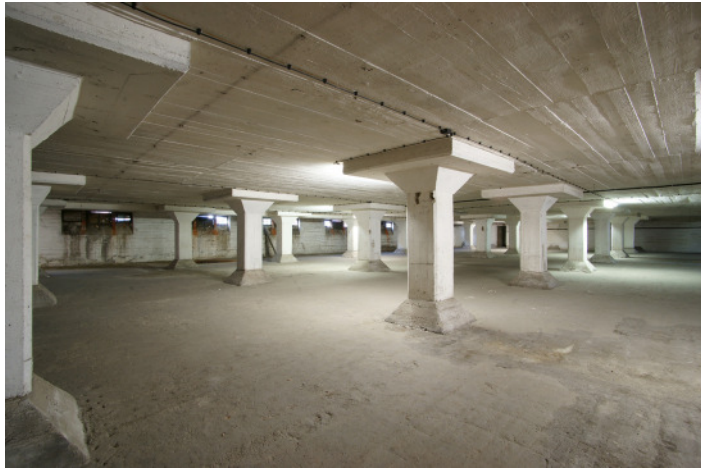
Bild unten: Der Keller unter dem südlichen Drittel des Schuppens F. Seine Breite umfasst auch die Tiefe der dem Obergeschoss vorgelagerten Rampen. Markant sind die Pilzkopfstützen in fünf Reihen mit ihrer großen Kopfplatte. In der Decke eingelassen sind auch die eingegossenen rechteckigen Holzdübel zu erkennen, die dazu dienen sollten, auch unter der Kellerdecke eine Wärmeisolierung anzubringen. Foto: Jörg Sellerbeck jr.
