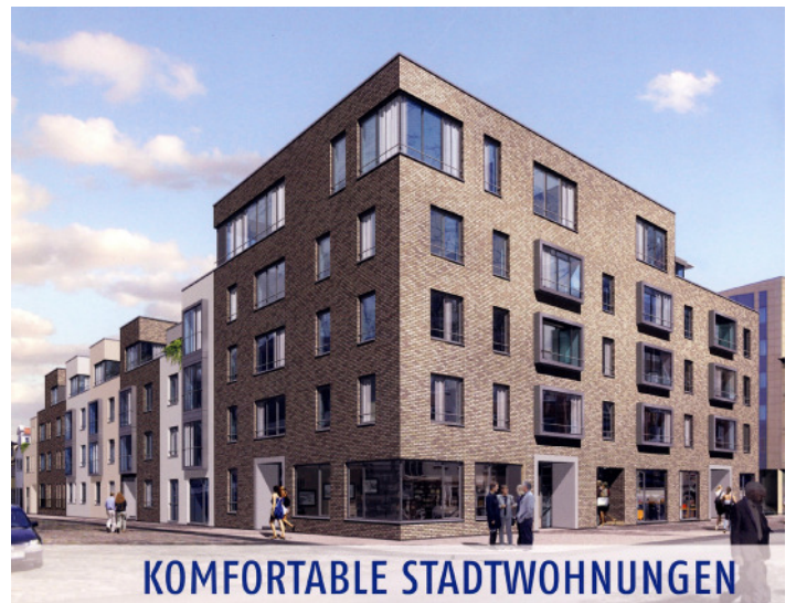
Oben: Ansicht der so genannten „Altstadthöfe“ im Prospekt der BIG-Immobilien GmbH: „Hochwertiges Wohnen auf historischem Grund“.
