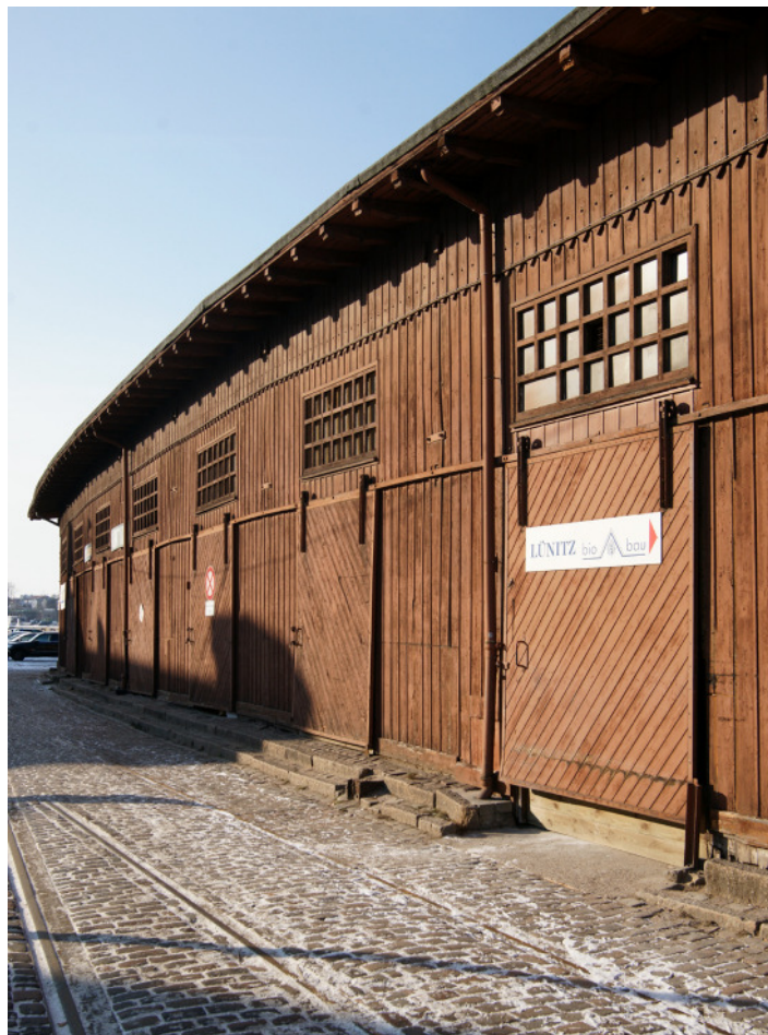
Stadtseitige Ansicht des Schuppens 9: Die Fassade folgt dem Verlauf der Gleisstränge der alten Hafenbahn, welche die Transportgüter an die Schuppentore lieferte, um nach Zwischenlagerung praktisch durch die Schuppen hindurch auf die Schiffe verladen zu werden.
