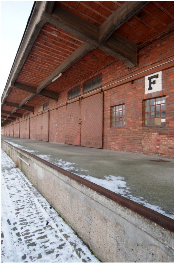
Die Nordwestliche Flanke von Schuppen F. Hier wird die Rampe von einem breiten Flugdach vor Regen geschützt. Sie besteht wie die Halle aus einer Stahlbeton-Rahmenkonstruktion, die die mit Beton vergossene Holzriegelreihen tragen. Fotos oben/ unten: Jörg Sellerbeck jr.
